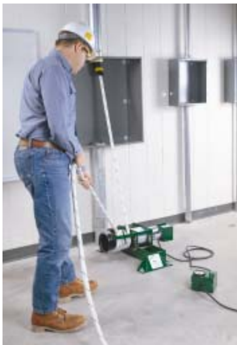
Спускающаяся тяга с напольной платформой, прикрепленной к полу.
